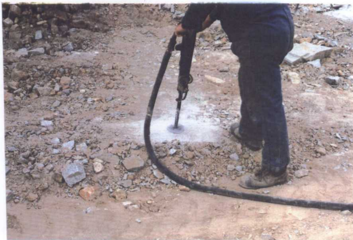
C-59.- Sistema particular del barrenista para protegerse contra el polvo
